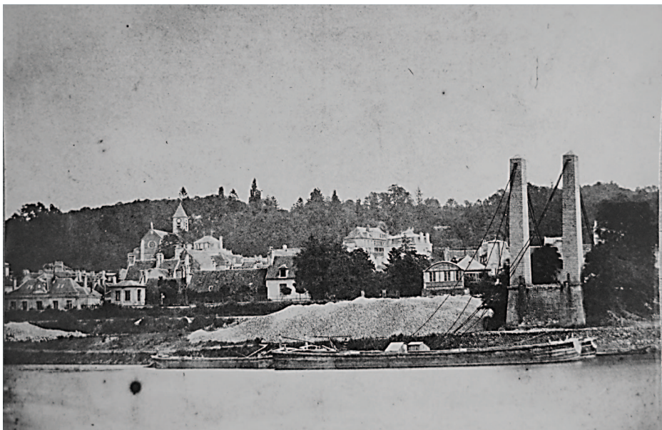
Pont suspendu de Villeneuve-Saint-Georges détruit également le 13 septembre 1870 par coupure des câbles et du tablier (©archives du Val de Marne)
