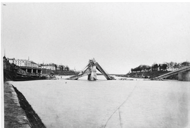
Pont de Choisy-le-Roi détruit à l'explosif le 13 septembre 1870 (© cliché ENPC)
