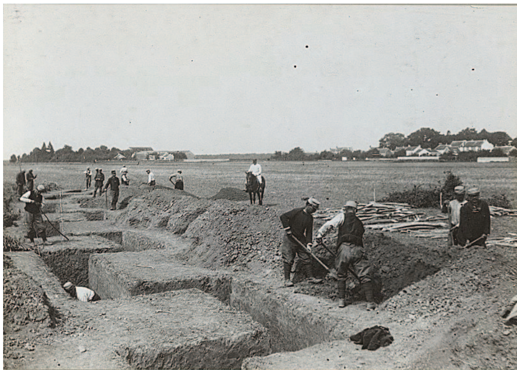
Sur cette photo, qui date d'août 1915, on voit des territoriaux de la 100 e division territoriale creusant des tranchées à la périphérie de la forêt de Sénart dans les champs entourant Tigery. Les restes des tranchées sont encore bien visibles en forêt de Sénart (© archives BDIC)
