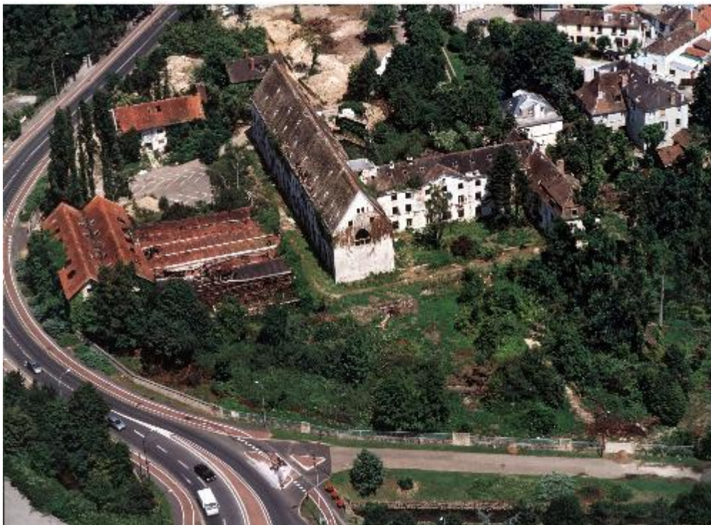
Photographie provenant des archives communales montrant l'état d'abandon du site en 1995
