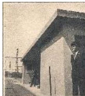
Le bâtiment de service
