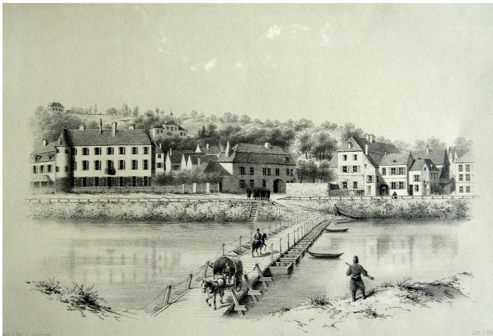
Site d'établissement du pont 25 avec son accès sous la voie ferrée et en face de la gendarmerie (archives du Val-de-Marne 2R 11)
