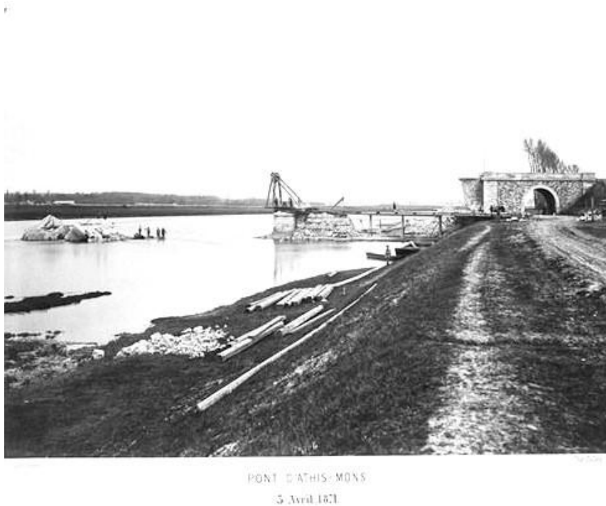
Pont voie ferrée d'Athis-Mons également détruit par le capitaine Marcille à la même date, déjà en début de réfection en avril 1871 (cliché ENPC)
