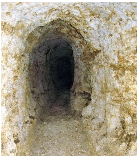
7) Un aqueduc souterrain à Crosne, par extension une pierrée ? La hauteur sous voûte est de l'ordre de 2 m.
