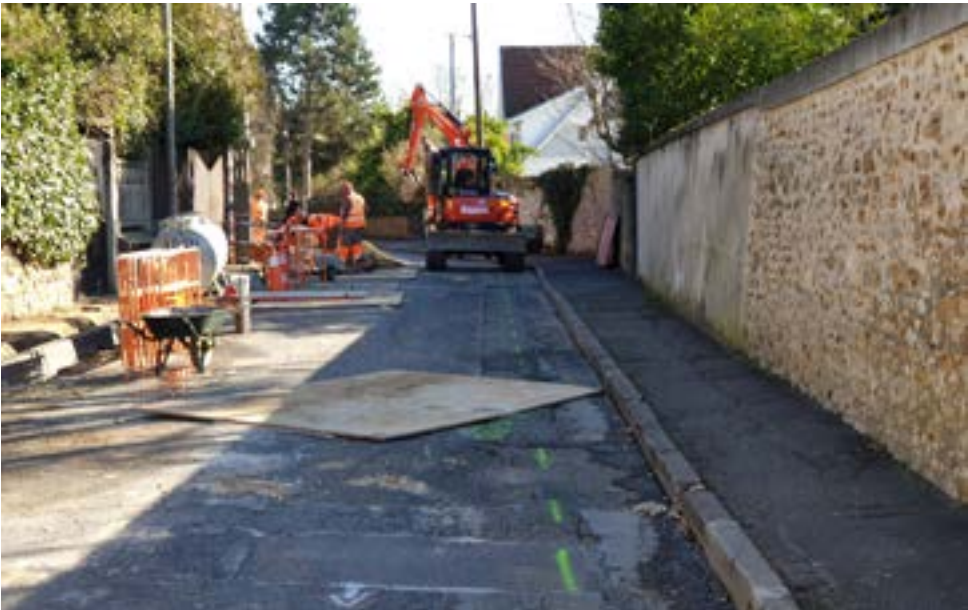
Les travaux de remplacement de la couche de roulement rue Danielle Casanova ont débuté en février. Le coût de ce chantier est de 154 000 euros.
