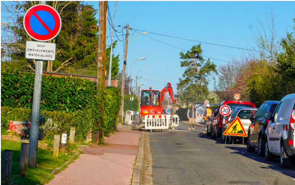
La chaussée de la rue Frédéric Koehler est en cours de réfection jusqu'à début mai. Auparavant, Suez est intervenu pour reprendre les amorces de branchements des canalisations d'eau et ainsi éviter toutes fuites ultérieures.
